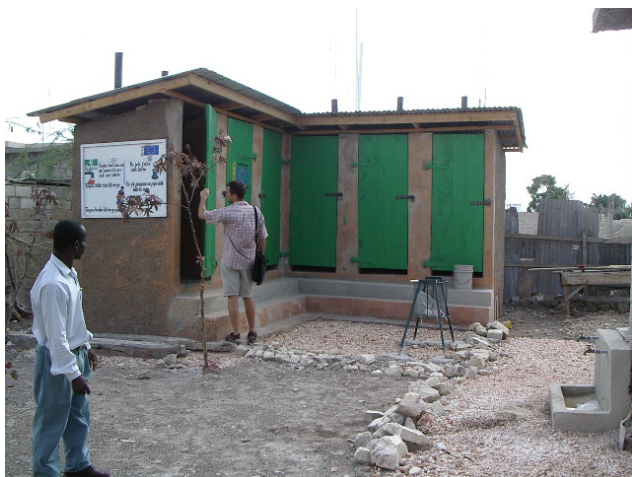
Fig 1 : Latrines sèches, surélevées, ventilées réalisées par l'Oxfam aux Gonaïves en 2004-05. A gauche panneau de sensibilisation à l'hygiène et poubelle. A droite trappe d'accès pour la vidange et bassin de rétention/compostage.
