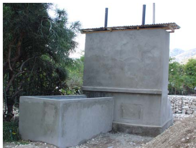
Fig 1 : Latrines sèches, surélevées, ventilées réalisées par l'Oxfam aux Gonaïves en 2004-05. A gauche panneau de sensibilisation à l'hygiène et poubelle. A droite trappe d'accès pour la vidange et bassin de rétention/compostage.
