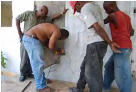
• L'opération de dépose du bas-relief
